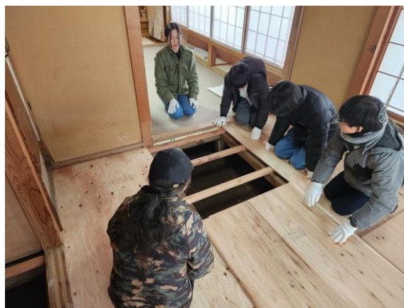
▲個別対応で行っている床板張りの作業
